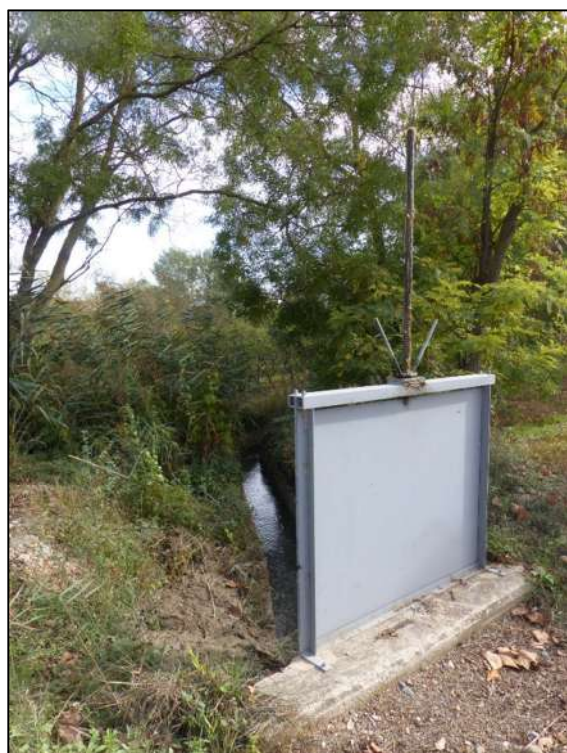
Figura 45. Fotografías de las diferentes tajaderas instaladas en las acequias a lo largo de la variante, tanto frente al tramo del Ebro, como ya frente al cauce del Ega.
