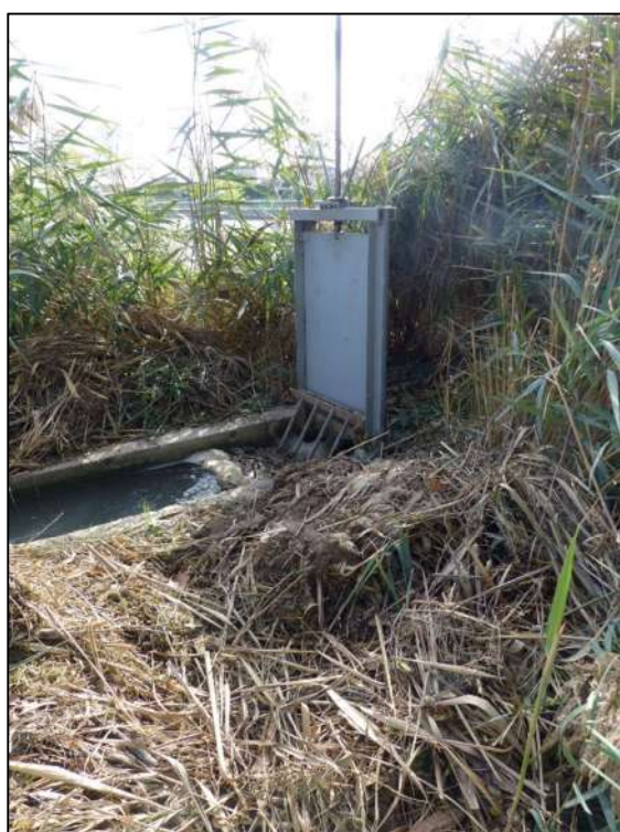
Figura 48. Fotografías de las tajaderas instaladas en las acequias que circulan por la margen derecha del río Ega en su tramo más bajo.
