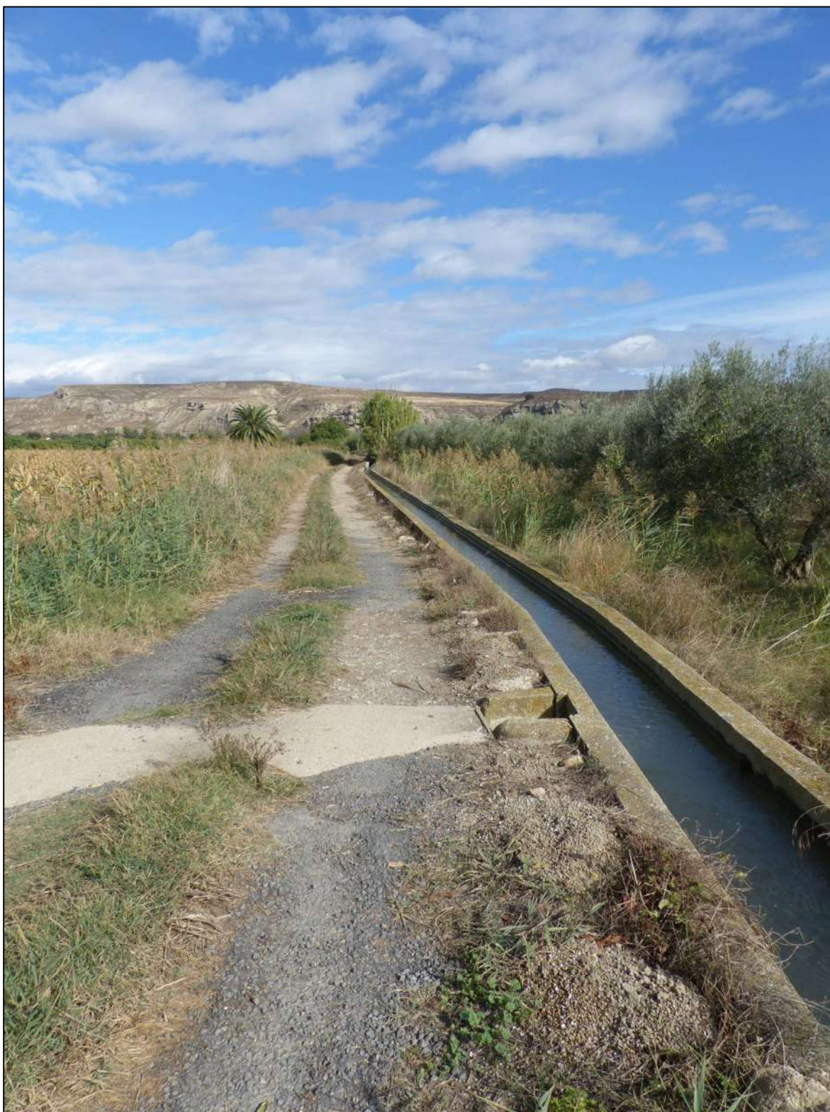
Figura 49. Camino que circula por la margen derecha del río Ega, y que, si es elevado, podría servir de defensa para evitar la inundación del casco urbano de San Adrián con aguas del Ega desde este punto.
