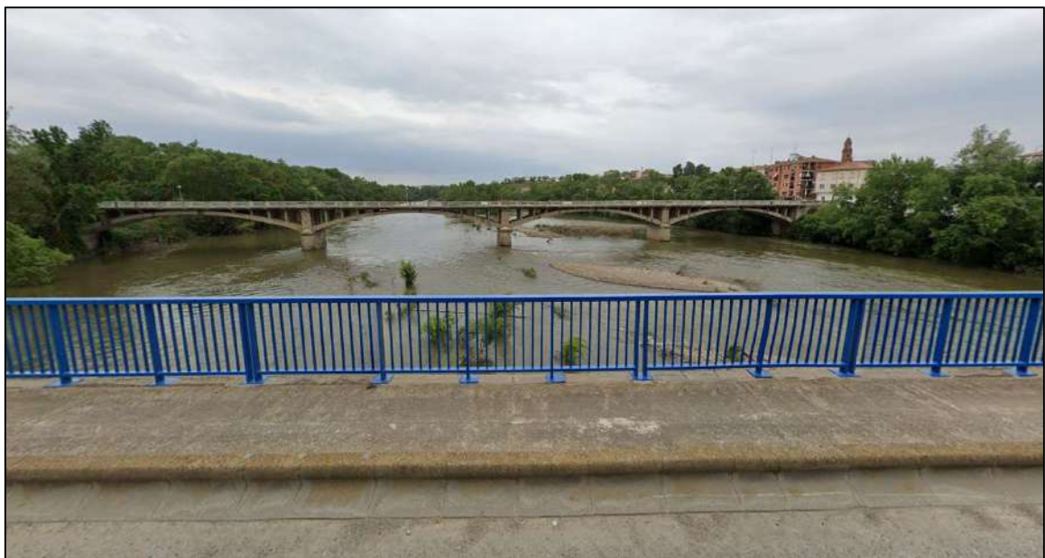
Figura 26. Imagen del puente antiguo de la localidad sobre el río Ebro, tomada desde el puente por el que circula la carretera NA-6531 que comunica con La Rioja. Imagen obtenida de GoogleMaps.
