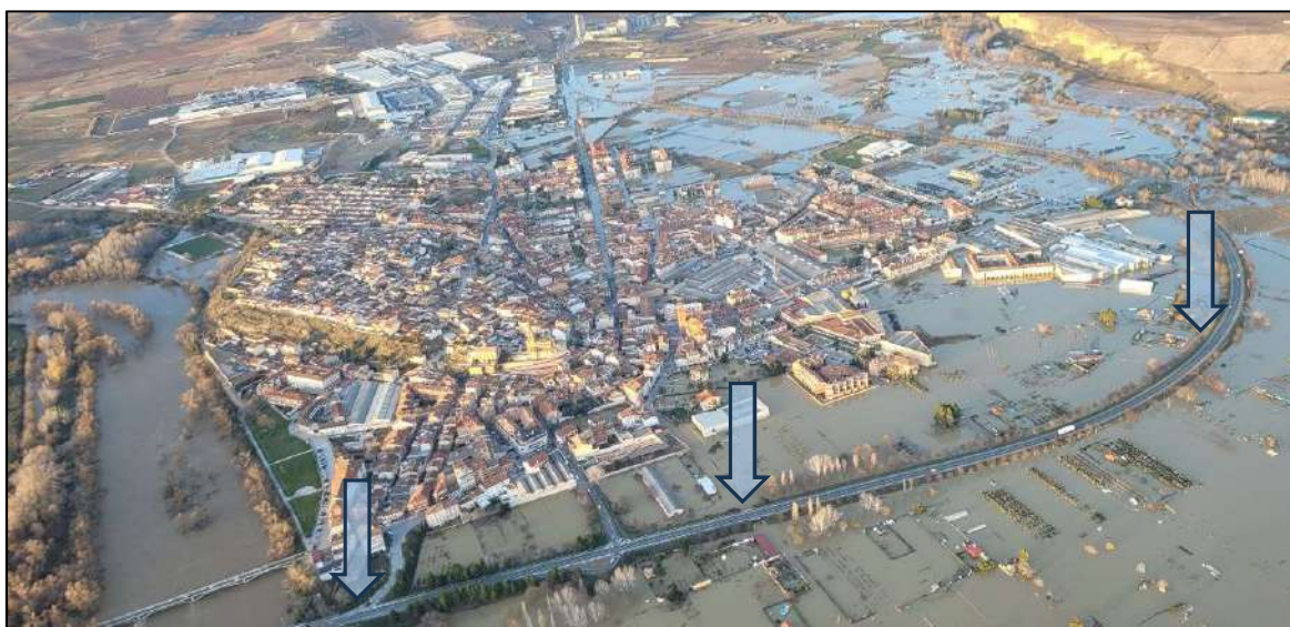
Figura 29. Imagen aérea de los desbordamientos del tramo del río Ebro a su paso por el término municipal de San Adrián. Detalle del trazado de la variante de la localidad en su tramo al sur del casco urbano. Imagen de la riada de los ríos Ega y Ebro en diciembre de 2021.
