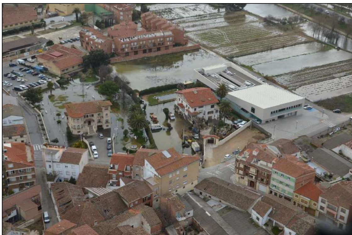
Figura 19. Imágenes aéreas de las afecciones causadas por los desbordamientos ocurridos a principios de febrero de 2015.
