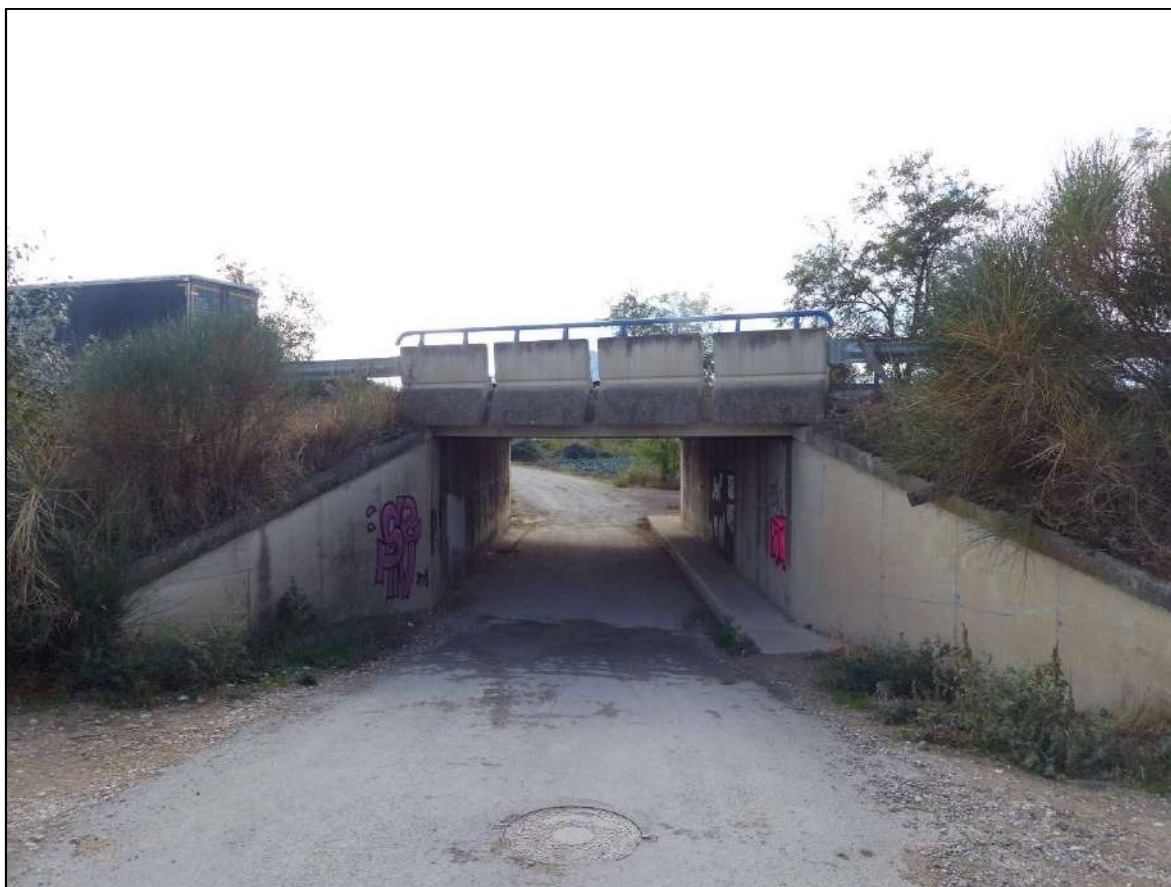
Figura 46. Fotografía del cuarto paso bajo la variante. Este paso se encuentra ya frente al cauce del Ega y no frente al cauce del Ebro como los tres pasos anteriores.
