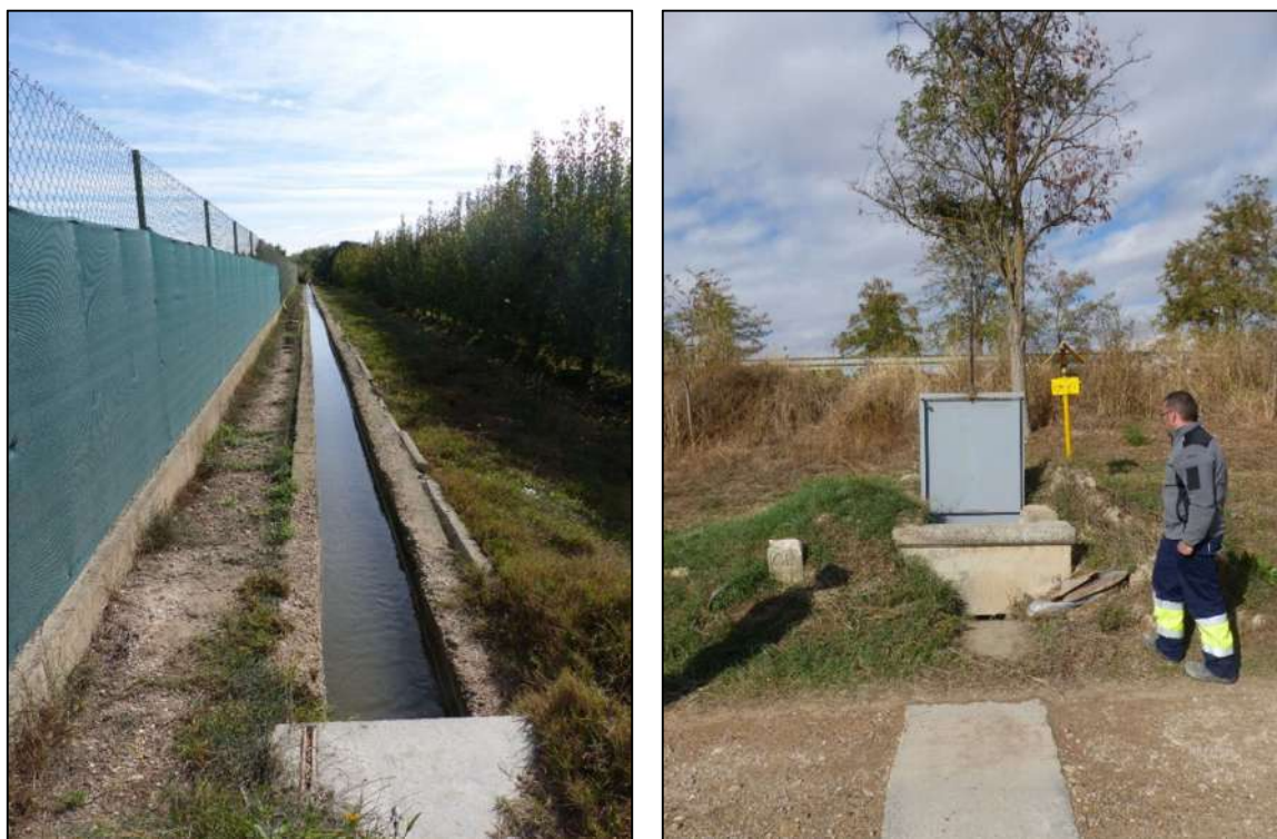
Figura 43. Segunda tajadera que debe ser cerrada para evitar la entrada del agua de inundación al casco urbano a través de las acequias de regadío en esta zona bajo la variante.
