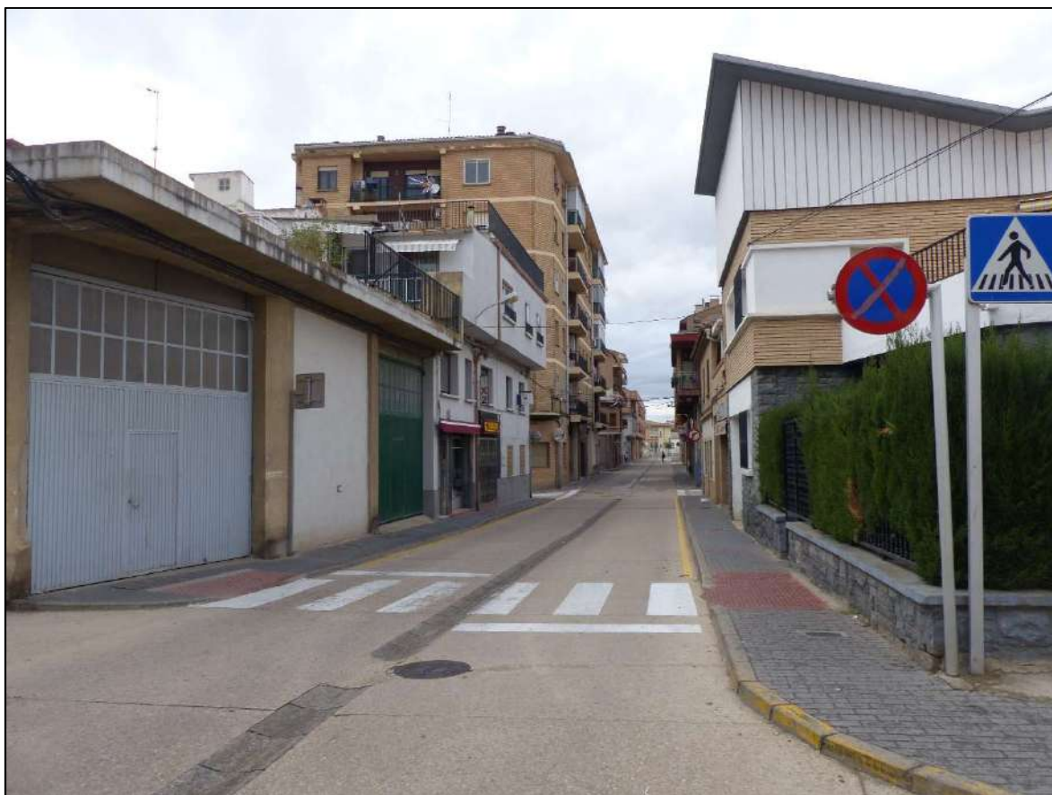
Figura 56. Zona del casco urbano en la que se encuentran los puntos de arquetas de pluviales a cotas más bajas y por las que se inicia la inundación del casco urbano desde dicha red de pluviales. Los primeros cortes de calles deben efectuarse en la zona de las calles Pelayo Sola y Ribera.
