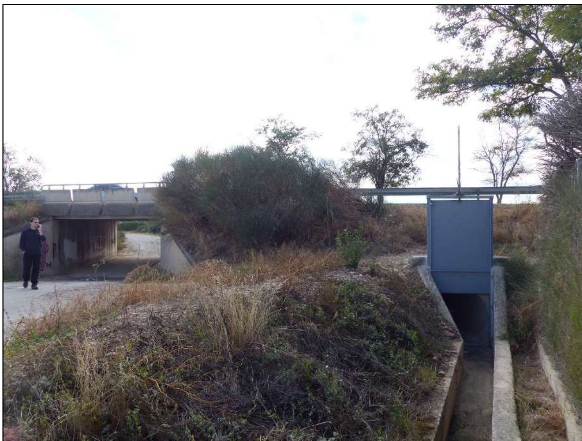
Figura 47. Imagen de la tajadera instalada en la acequia más próxima al cuarto de los pasos de la variante.
