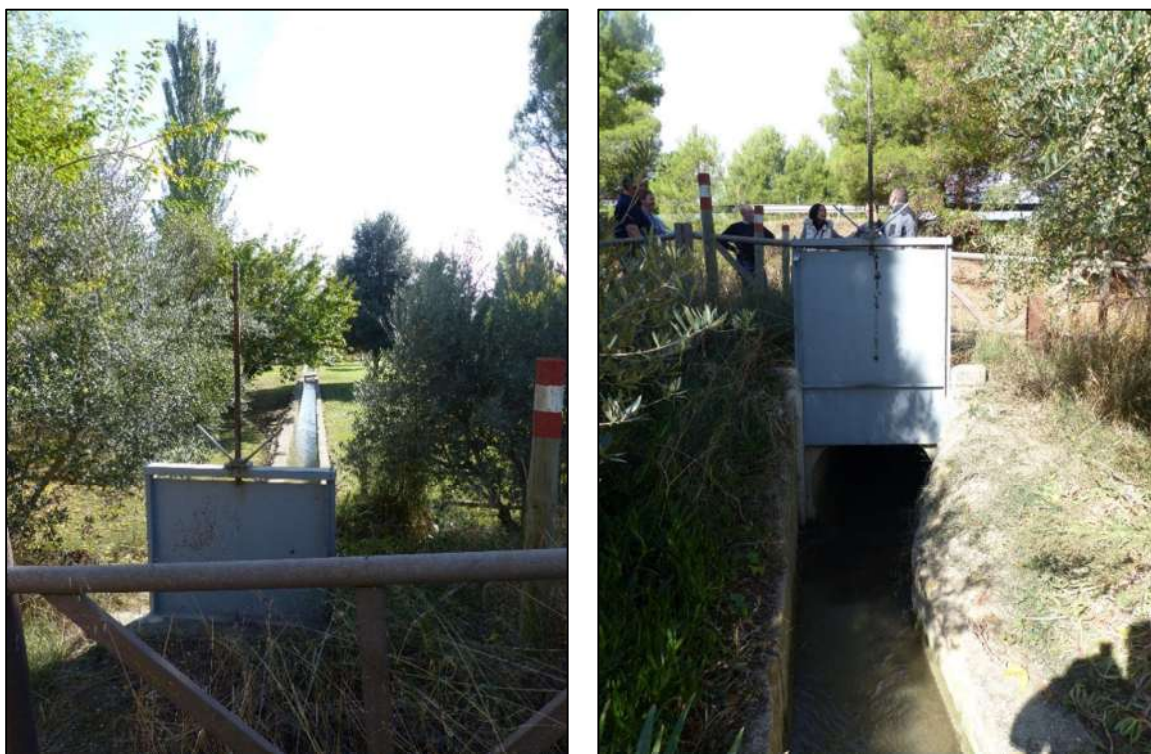
Figura 41. Fotografías de la primera tajadera visitada, ya en la zona del Plantío. Se trata de una serie de tajaderas instaladas recientemente en las acequias principales, en puntos bajo la variante, y que deben cerrarse en fases iniciales del plan de emergencias para evitar que el agua desbordada de Ega y Ebro llegue a entrar a la zona urbana del municipio.
