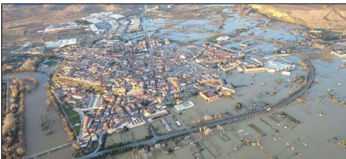
Figura 22. Vista aérea de la inundación del casco urbano de San Adrián durante la riada de diciembre de 2021.
