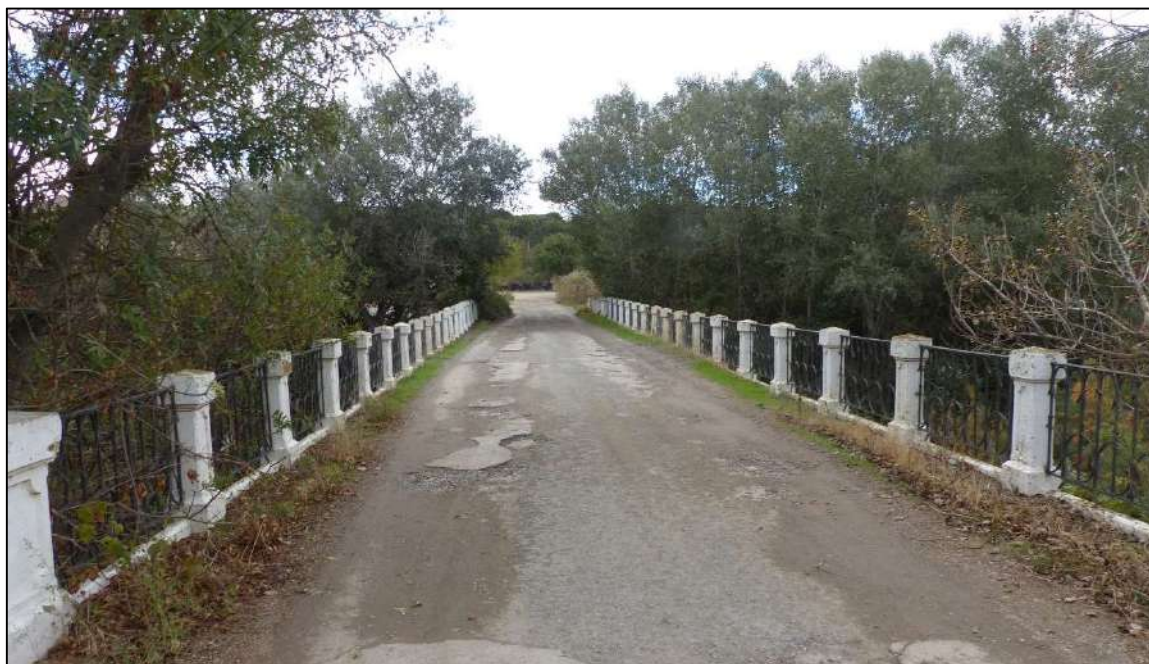
Figura 27. Fotografía, tomada durante la visita de campo a la localidad, del antiguo puente de la carretera sobre el río Ega.
